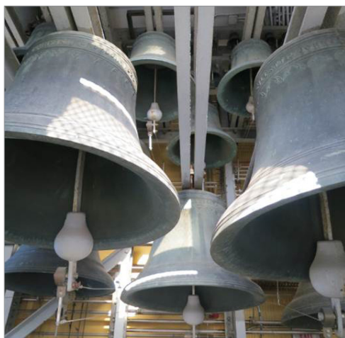
▲ Petites et moyennes cloches (suspendues dans la partie supérieure de la cage où sont logées les cloches du carillon de la Tour de la Paix) qui ont été conçues, coulées et accordées entre 1925 et 1927 par Gillett & Johnston (une entreprise britannique spécialisée dans la fabrication des carillons).
