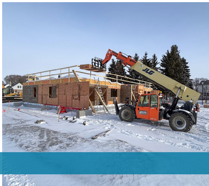
Image 1: Le point sur les travaux de construction à Edmonton, janvier 2025.
