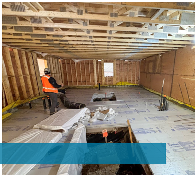
Image 2: Le point sur les travaux de construction à Edmonton, février 2025.
