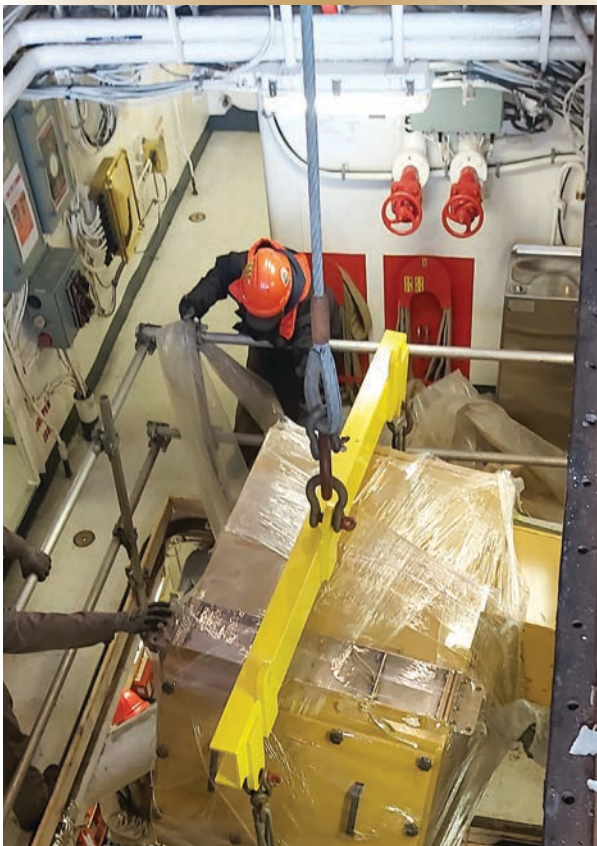
Figures 3a et 3b. Un nouveau groupe électrogène Hitzinger est déplacé dans le hangar du navire et abaissé dans la salle des machines auxiliaires arrière.
