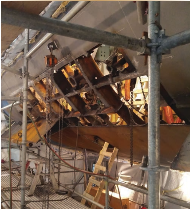
Figure 3. L'ouverture rectangulaire de 18 m 2 commençait de la salle des machines arrière et se terminait juste à l'intérieur de la salle des machines avant.
