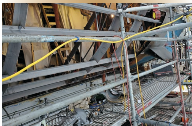
Figure 1. Échafaudages installés à l'intérieur de l'enclos protecteur contre les intempéries, avec le bordé latéral du navire et la section de la quille de roulis retirés.
