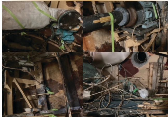
Figures 2a & 2b. Le premier obstacle consistait à terminer l'enlèvement des nombreux éléments gênants à l'intérieur du navire qui bloquaient l'accès complet aux membrures, aux lisses et au bordé de coque.
