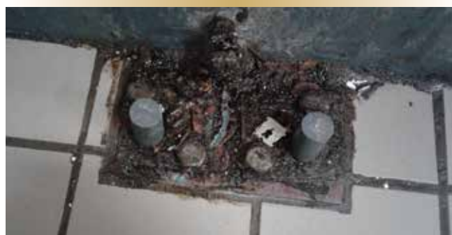
Figure 6. Raccord d'appareils de cuisine gravement corrodé.
