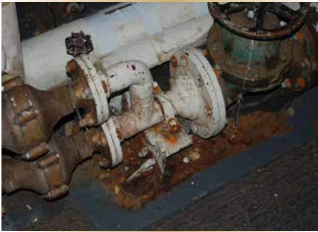
Figure 9. Le problème relatif à l'utilisation de métaux dissemblables de l'utilisation de métaux différents pour les interfaces de raccord.
