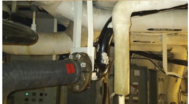
Figure 2. Alimentation et retour d'eau réfrigérée.
