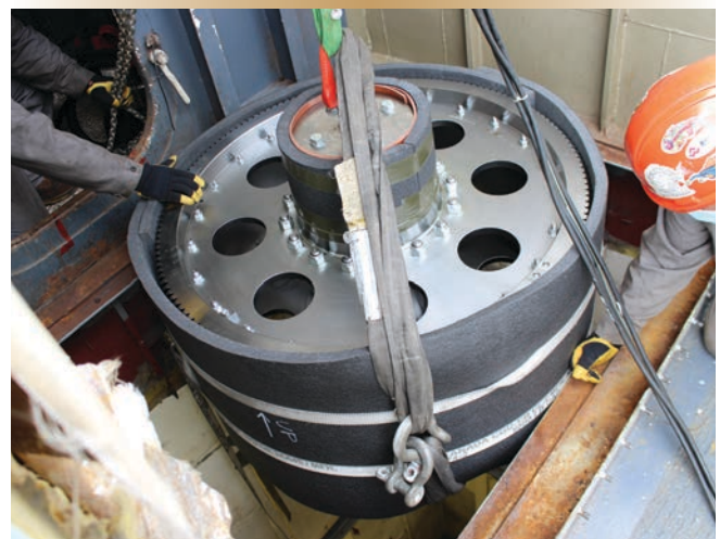
Figure 2. Le nouvel engrenage est abaissé dans le placard à joint plastique malgré un dégagement de quelques millimètres à peine.
