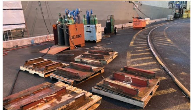
Figure 4. Plutôt que de tenter de sauver de courtes sections de lisse, on a coupé des sections complètes du bordé extérieur et des lisses.
