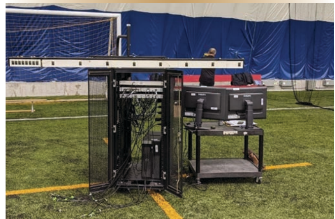
Figure 13. Radar MIMO à l'intérieur du dôme.
