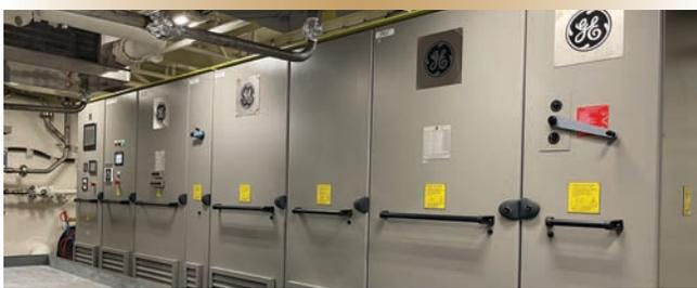
Figure 1. Armoires de convertisseurs dans la salle des moteurs supérieure tribord à bord du NCSM *Margaret Brooke* (AOPV-431).
