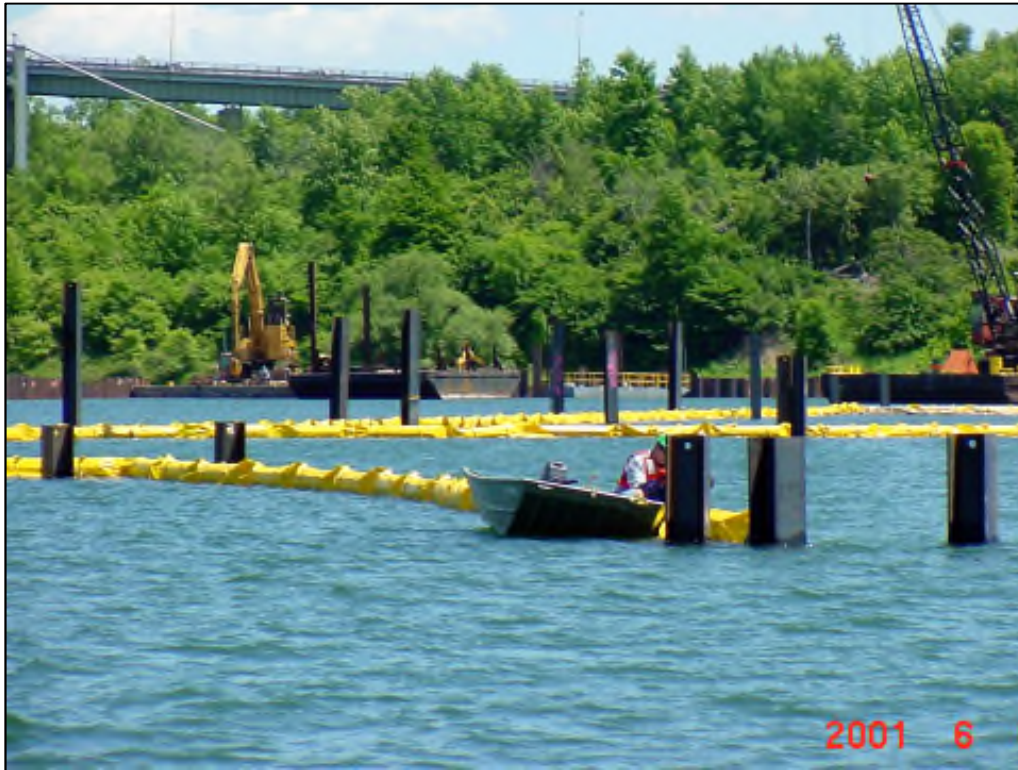
Figure 3-12 : Utilisation d'une barrière de rétention de limon (reproduction autorisée par ECCC).
