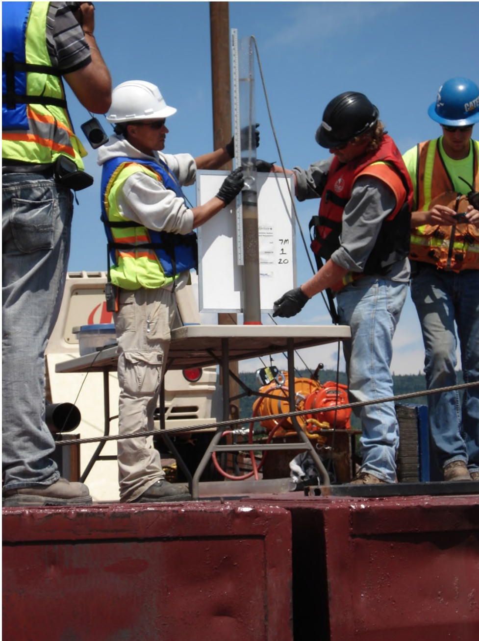
Figure EC2-6 : Vérification par carottage de l'épaisseur du recouvrement (reproduction autorisée par AECOM).
