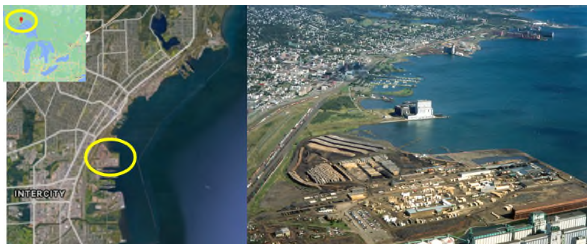
Figure EC1-1 : Carte de localisation de la Northern Wood Preservers à Thunder Bay, en Ontario, au Canada (reproduction autorisée par ECCC).
