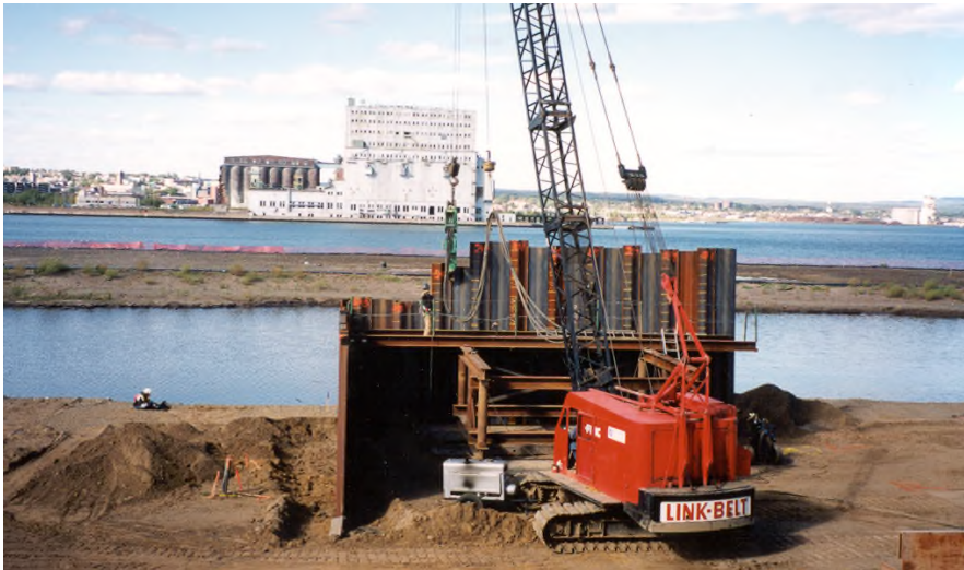
Figure EC1-6 : Installation de la barrière en écrans de palplanches d'acier de marque Waterloo Barrier MD (reproduction autorisée par ECCC).
