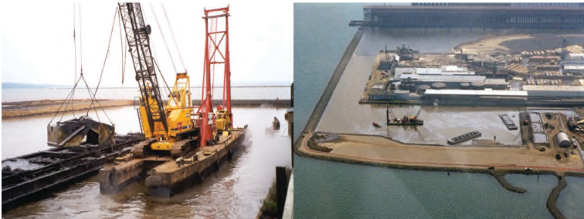
Figure EC1-4 : Dragage de sédiments contaminés à l'aide d'une drague environnementale à benne preneuse Cable Arm et déposés sur un chaland (à gauche) et une vue d'ensemble de la manipulation des sédiments, de leur assèchement et de la zone de stockage temporaire (à droite) (reproduction autorisée par ECCC).
