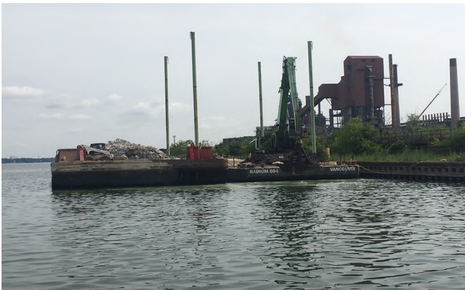
Figure EC4-8 : Mise en place d'un tapis de matériaux réactifs (en haut) et prévention de l'érosion (en bas) (reproduction autorisée par Riggs Engineering).
