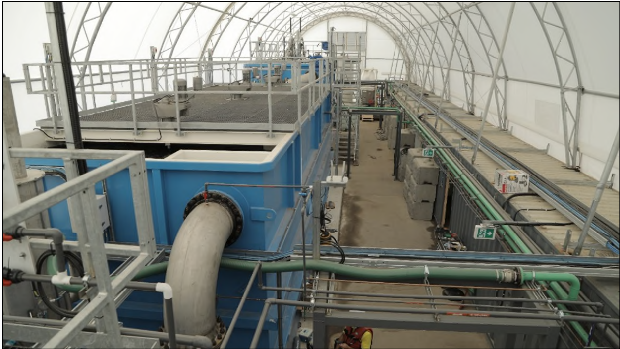
Figure 3-18 : Cellules de décantation dans un système de traitement de l'eau du projet d'assainissement des sédiments du récif Randle (reproduction autorisée par ECCC).
