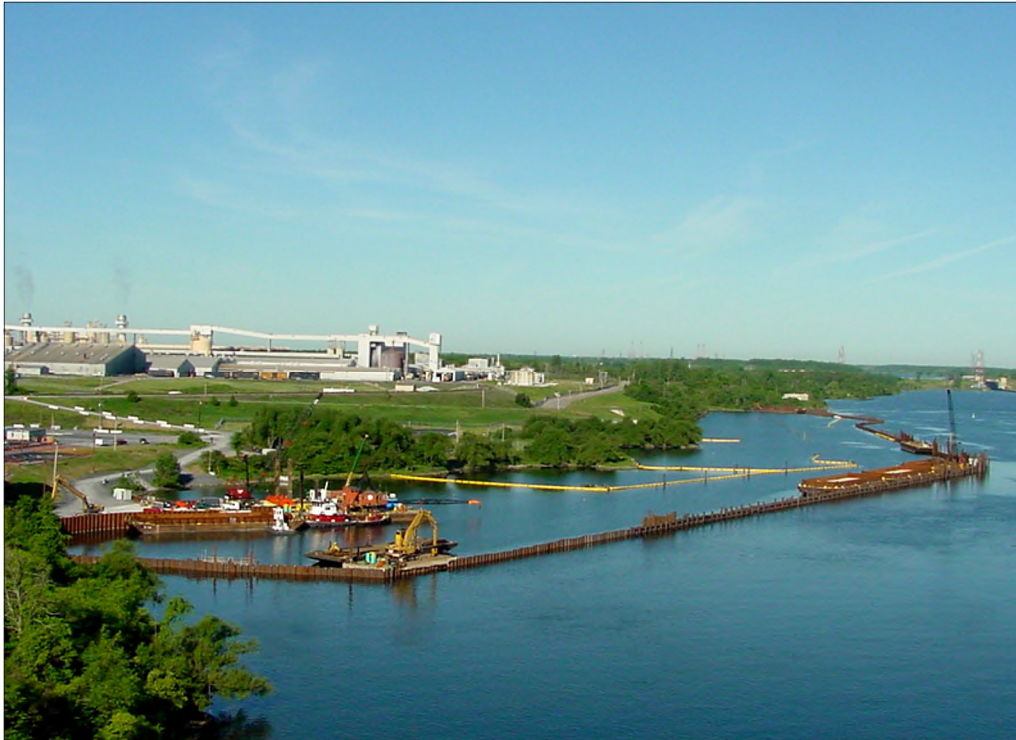
Figure 3-11 : Confinement temporaire au moyen de palplanches (reproduction autorisée par ECCC).
