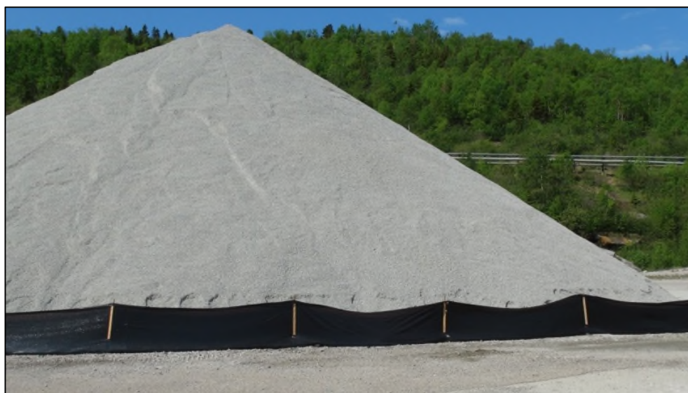
Figure EC2-5 : Clôtures anti-érosion autour du sable empilé (matériau de recouvrement) (reproduction autorisée par ECCC).
