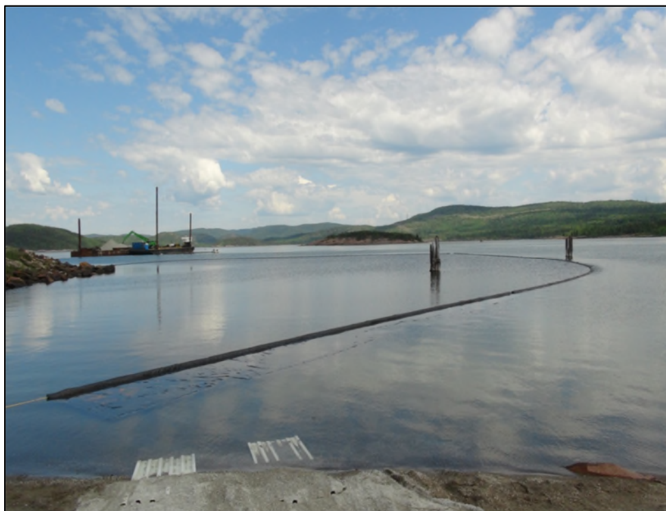
Figure EC2-4 : Barrières de rétention de limon autour d'habitats près du rivage pour protéger l'habitat du poisson (reproduction autorisée par ECCC).
