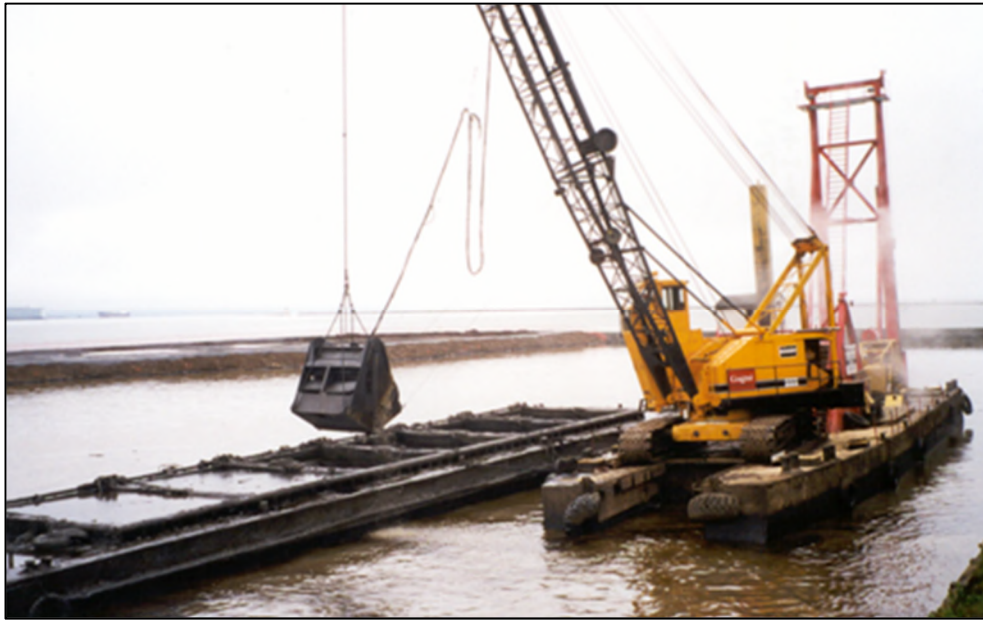
Figure 3-4 : Dragage mécanique avec chaland (reproduction autorisée par ECCC).
