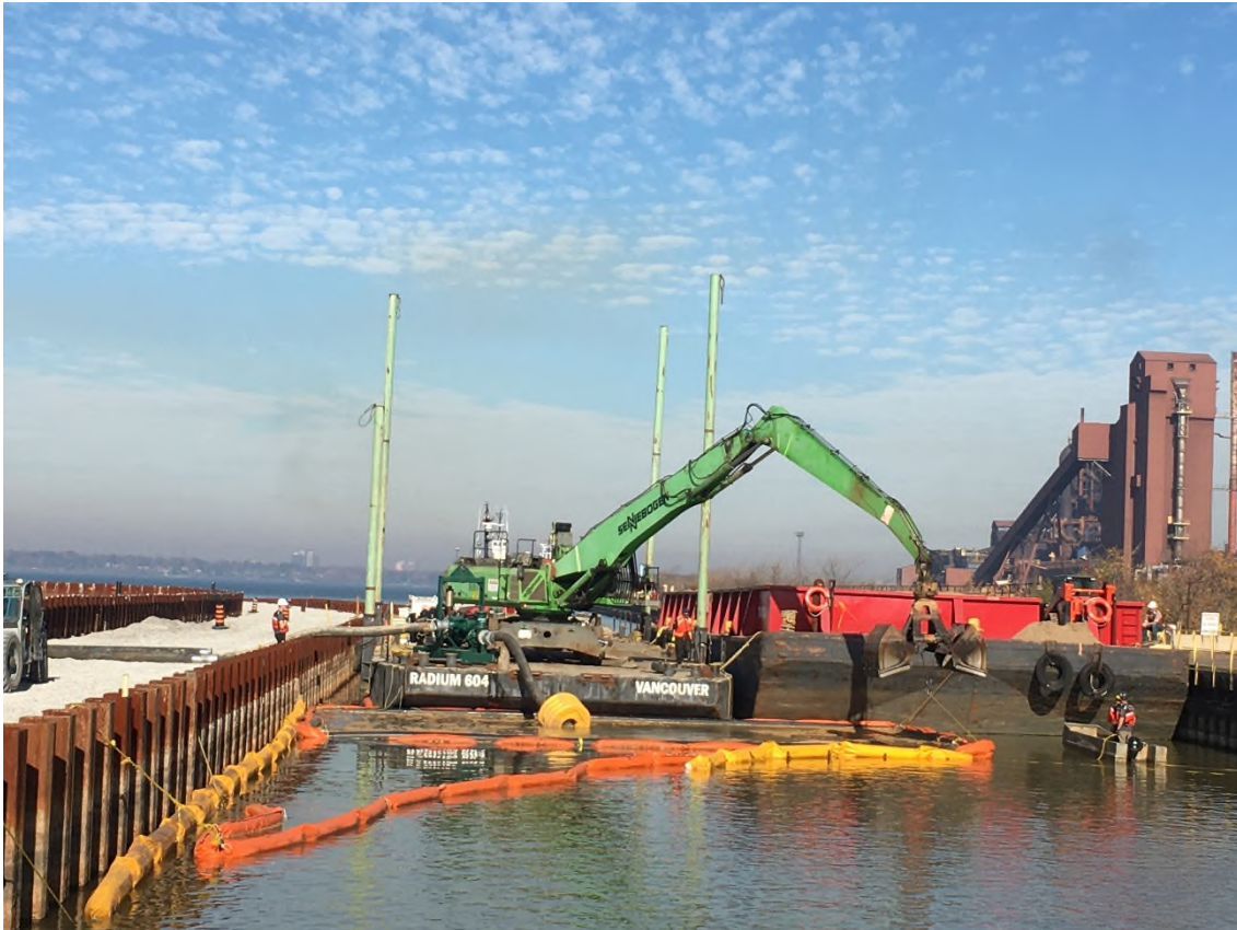
Figure EC4-7 : Mise en place du sable dans le recouvrement sous le canal de la Stelco (reproduction autorisée par Riggs Engineering).
