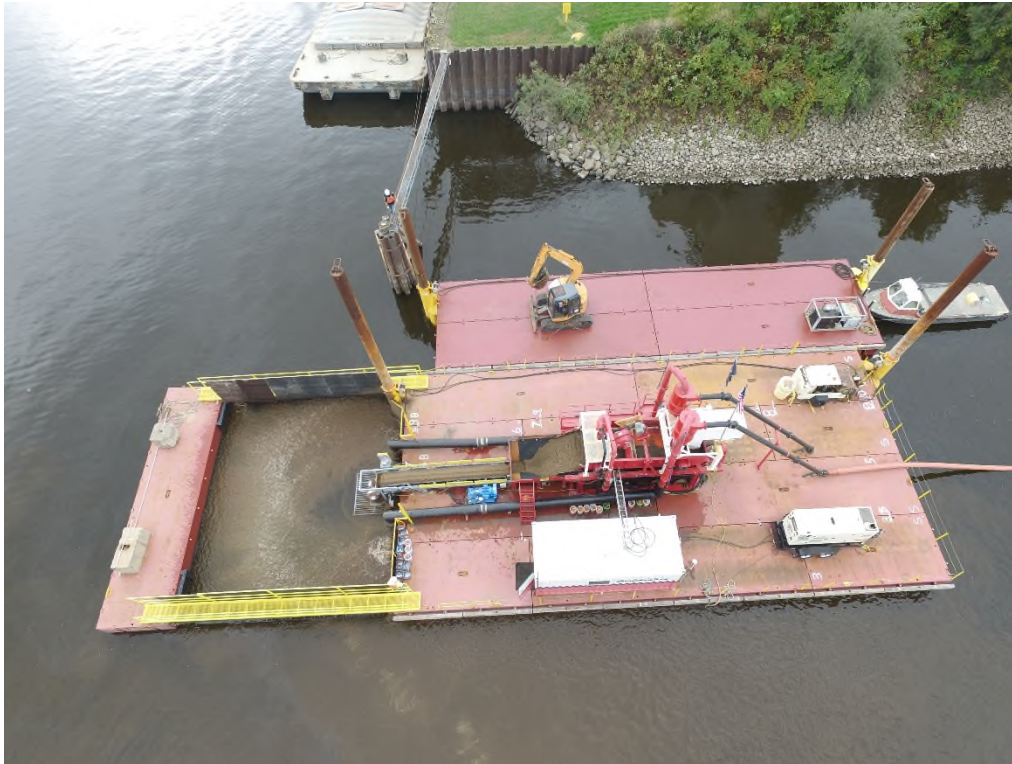
Figure 5-11 : Épandeuse utilisée pour un recouvrement au site de Fox River (Wisconsin) [reproduction autorisée par J.F. Brennan Company inc.].
