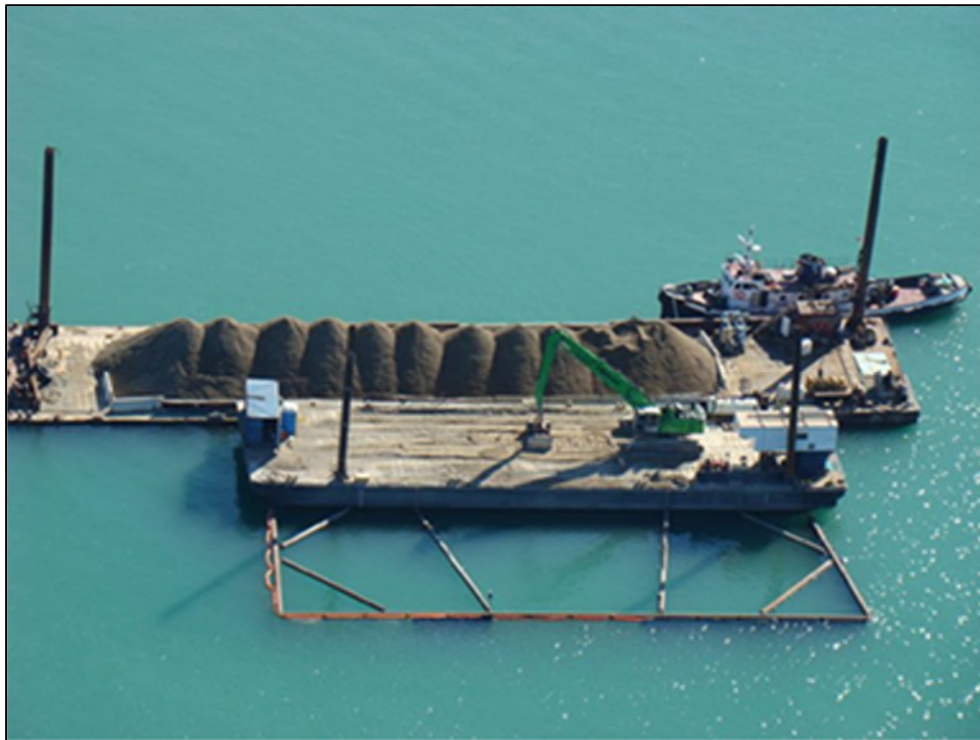
Figure EC2-3 : Barrière de rétention de limon flottante suspendue à une boîte autour de la cellule de mise en place pour limiter le mouvement des fines (reproduction autorisée par Pacific Productions).
