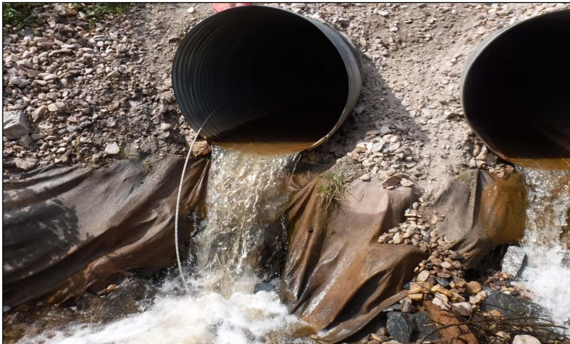
Photo 4. Ponceaux d'où s'écoule l'émissaire du bassin Dyno, présence d'une petite fosse au pied du ponceau de gauche (3 juillet 2019)
