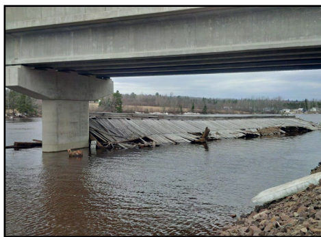
Le pont de Cherryvale de 87 ans a été emporté par les eaux de crue à la mi-avril. Crédit : Ministère des transports et de l'infrastructure du Nouveau-Brunswick
