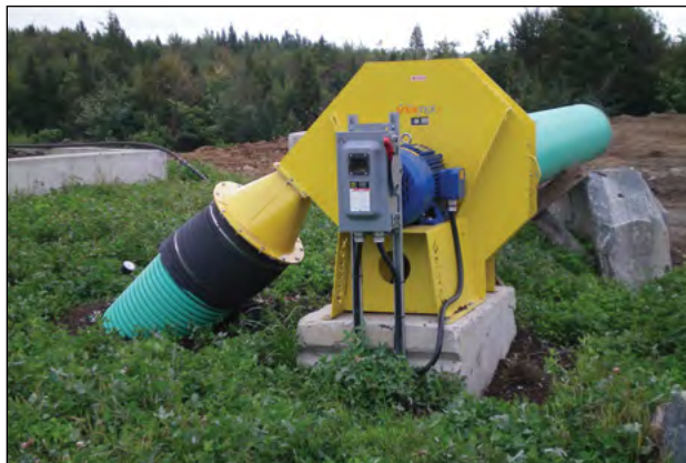
Photo 8-3 : Les ventilateurs utilisés aux installations de compostage requièrent généralement un approvisionnement en électricité en trois phases. © CH2M HILL
