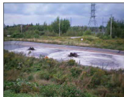
Photo 10-9 : Les eaux pluviales contaminées sont couramment recueillies dans les bassins de rétention et réutilisées dans le processus de traitement. © CH2M HILL
