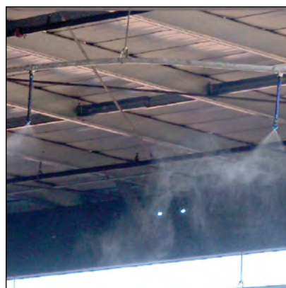
Photo 15-2 : Les systèmes de brumisation directionnels installés au plafond dans les bâtiments et autour de l'équipement permettent un contrôle efficace du niveau de poussière. © CH2M HILL
