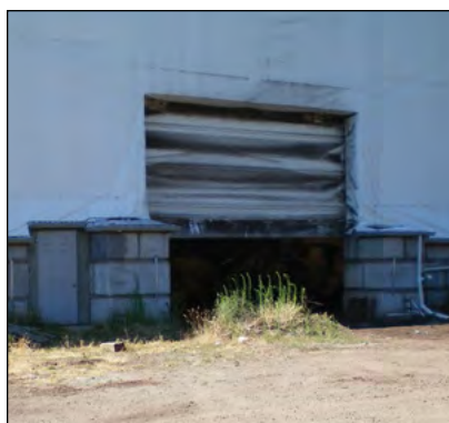
Photo 9-7 : Laisser les portes ouvertes entrave la capacité des systèmes de ventilation du bâtiment à contenir les odeurs. © CH2M HILL
