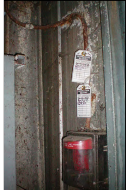
Photo 9-3 : Les systèmes de détection et d'alarme incendie à l'intérieur des installations de traitement des matières organiques sont particulièrement sensibles à la corrosion. © CH2M HILL
