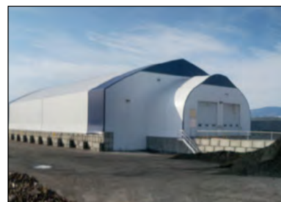
Photo 10-2 : Bâtiment de réception avec revêtement de style tissu © CH2M HILL
