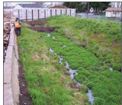
Photo 10-10 : Les bermes filtrantes et les rigoles de drainage biologiques peuvent être une manière rentable de retirer les sédiments des eaux pluviales non contaminées. © Scott Gamble
