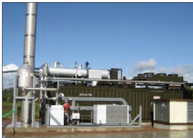
Photo 7-1 : Système compact de production de chaleur et d'électricité © CH2M HILL
