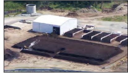
Photo 5-10 : Système de compostage en larges piles sur le point d'être retournées; il est important de constater l'emplacement du vire-andain en bas à gauche de la pile et l'allée créée derrière le vire-andain. © Lenz Enterprise Inc.
