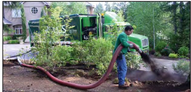
Photo 17-1 : Les camions souffleurs sont couramment utilisés pour épandre le compost dans le cadre des applications de contrôle de l'érosion. © Rexius Forest By-Products Inc.
