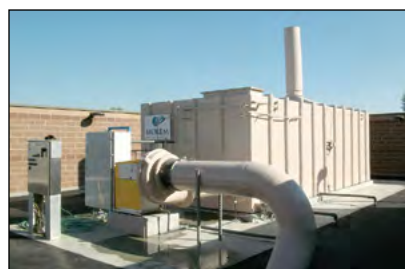
Photo 14-8 : Système à biofiltre fermé utilisé dans une installation de compostage © Biorem Technologies Inc.
