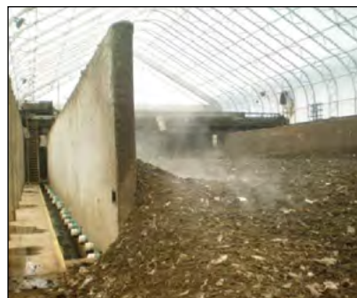
Photo 5-26 : Système de lit agité vu du côté de déchargement de l'aire de compostage © CH2M HILL
