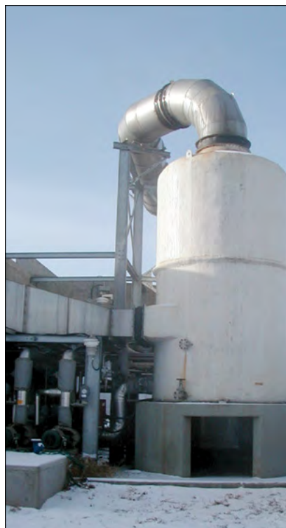
Photo 14-4 : Tour à garnissage dans une installation de compostage © CH2M HILL
