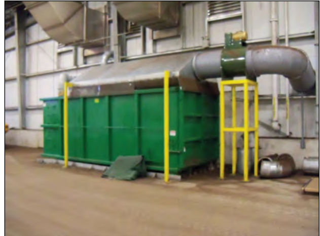
Photo 10-7 : Des conteneurs mobiles fermés peuvent être utilisés pour contenir les débris et les matières résiduelles occasionnés par les opérations de prétraitement et de tamisage. © CH2M HILL
