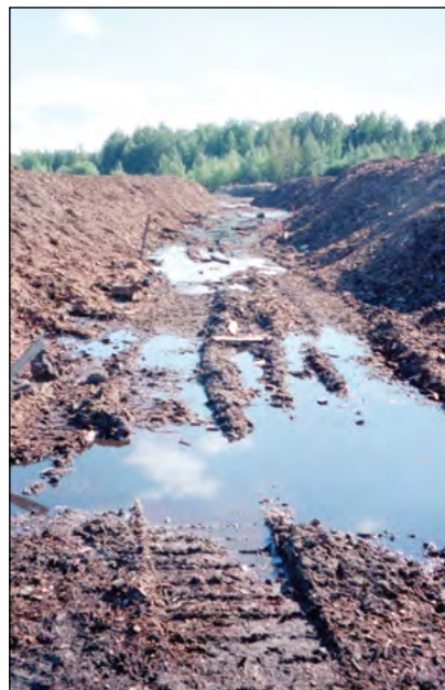
Photo 15-8 : Les ornières limitent le passage, attirent les insectes et constituent une source d'odeurs. © CH2M HILL
