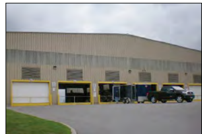
Photo 9-11 : Installation de gestion des déchets équipée de portes receptrices pour le trafic lié aux livraisons par les résidents qui sont complètement séparées des portes utilisées par les gros véhicules de collecte des déchets. © CH2M HILL
