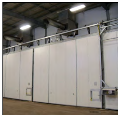
Photo 5-18 : Système de fermeture de la porte du tunnel © CH2M HILL
