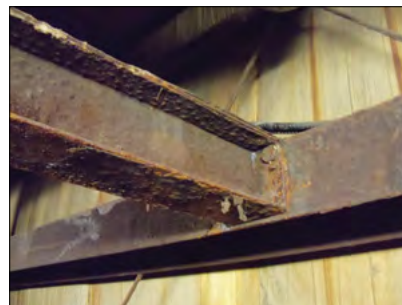
Photo 9-12 : La corrosion s'est avérée être l'une des plus importantes difficultés en matière de conception pour l'industrie de traitement des matières organiques. © CH2M HILL
