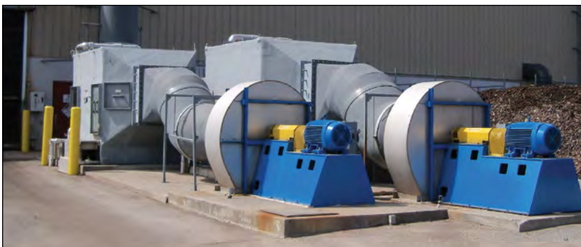
Photo 14-5 : Épurateur à bruite atomisée © CH2M HILL
