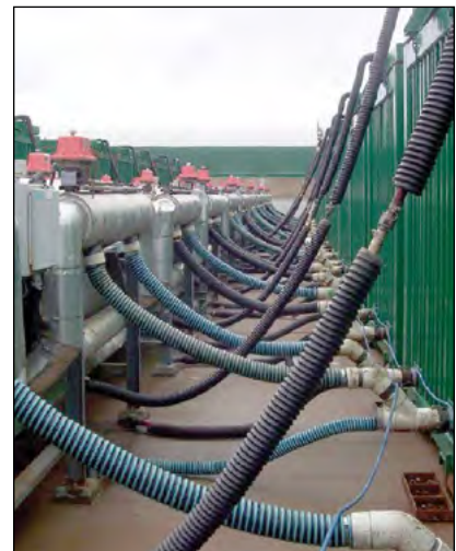
Photo 5-22 : Chaque conteneur statique est relié à un système d'air central à l'aide de tuyaux flexibles © CH2M HILL
