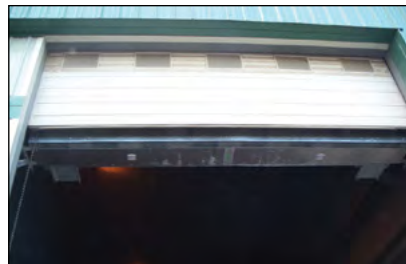
Photo 10 5 : Rideau d'air installé au-dessus d'une porte de garage © CH2M HILL
