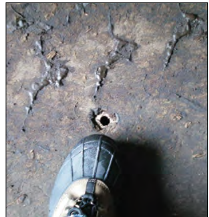
Photo 5-12 : Aération intégrée au sol avec un système de tuyaux et d'embouts; la photo intérieure montre un système avant le versement du plancher en béton. © CH2M HILL
