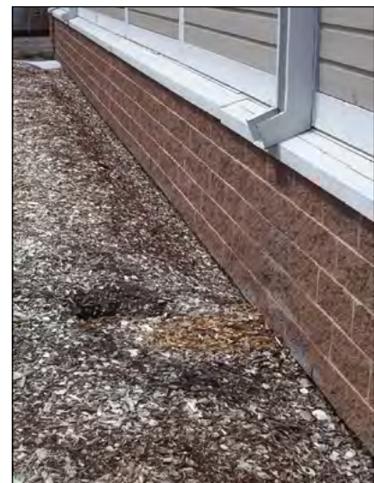
Photo 10-11 : L'eau évacuée des toits devrait être dirigée autour des zones d'exploitation pour minimiser la quantité d'eau de surface contaminée qui doit être recueillie et traitée. © Scott Gamble
