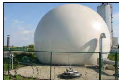
Photo 4-1 : Réservoir de stockage du biogaz © Organic Waste Systems Inc.
