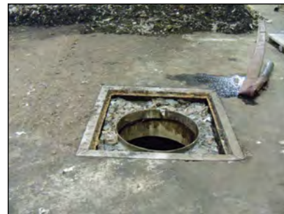
Photo 10-8 : Les puisards et les réservoirs souterrains sont couramment utilisés pour recueillir et entreposer le lixiviat fortement chargé. © CH2M HILL
