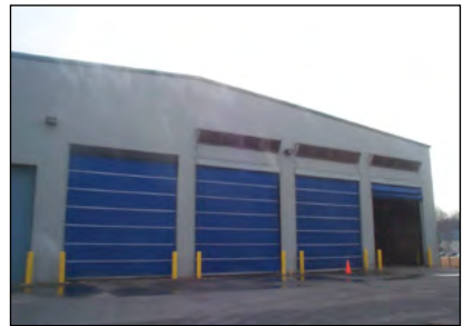
Photo 10-4 : Portes de garage en caoutchouc à cycle rapide utilisées à une installation de compostage © Scott Gamble
