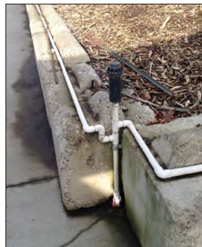
Photo 14-7 : L'eau peut être ajoutée au substrat à l'aide de gicleurs, mais on doit veiller à ne pas trop mouiller le substrat. © CH2M HILL
