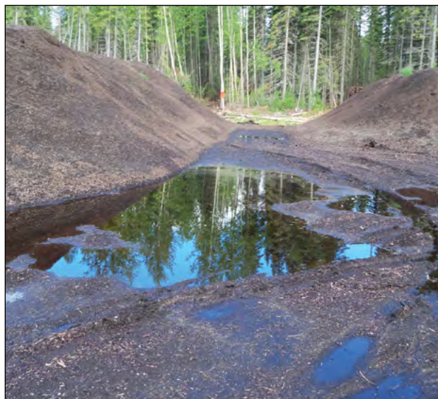
Photo 10-6 : L'accumulation d'eau dans l'aire d'entreposage des produits d'une installation de compostage peut perturber l'accès et entraîner la formation d'odeurs. © CH2M HILL
