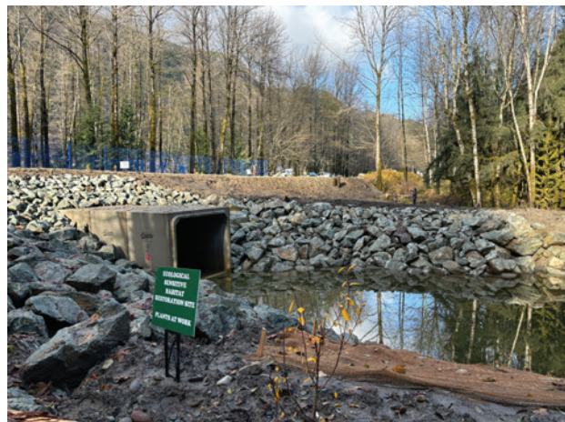
Des mises à niveau des dalots restaurent l'échange maréal côtier naturel entre la rivière, l'estuaire et l'océan, même à marée basse ou pendant les périodes de débit minimal. (Photo par Sydney Bryce, MPO)
