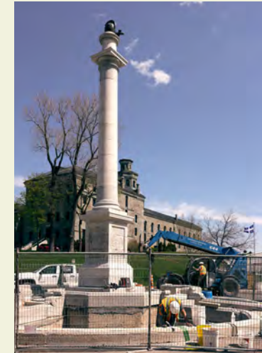
Travaux de restauration du monument Wolfe
