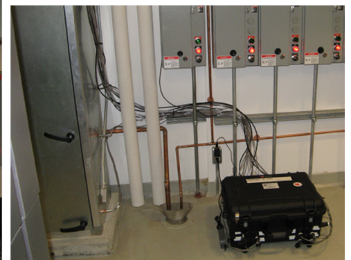
Figure 4 : Triplex du campus de la SCREA, appareil bibloc et système d'enregistrement de données dédié déployés.
