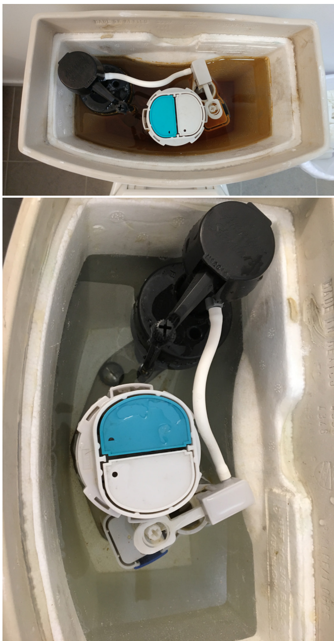
Figure 8 : Réservoir de toilette avant (gauche) et après (droite) avoir été nettoyé et tiré la chasse d'eau avec les eaux grises traitées.
