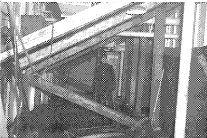
Le capitaine Lay, commandant du HMS Nabob , inspectant un étançonnement d'urgence.
