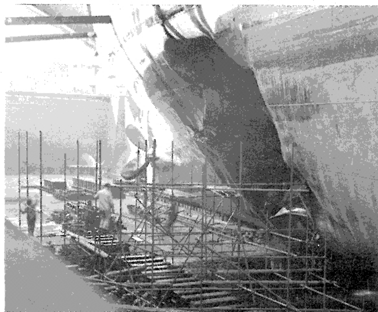
Le HMS Nabob en cale sèche à Rosyth—Vue des dommages causés par le torpillage.
