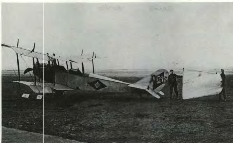
Avion JN4a à cible, utilisé par l'école d'artillerie du Camp Borden pour des exercices aériens de tir à la mitrailleuse. Contrairement à ce que l'on voit sur cette photographie, la cible n'était pas aussi près de l'appareil. (RE 20804-3)
