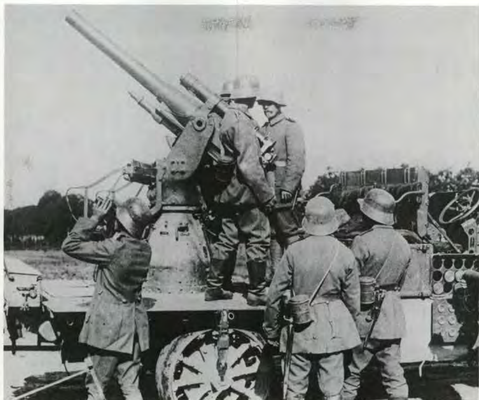
Canon anti-aérien de 77 mm, monté à l'arrière d'un camion. (AH 487)
