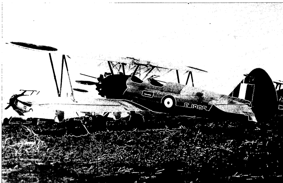
Un des 300 Stearman dont on avait fait l'acquisition, en 1940, pour la 31 ème École élémentaire de pilotage à De Winton (Alberta). Parce qu'ils ne comportaient pas de poste de pilotage fermé, ils étaient inutilisables pour l'entraînement en hiver. (PMR 77-148)
