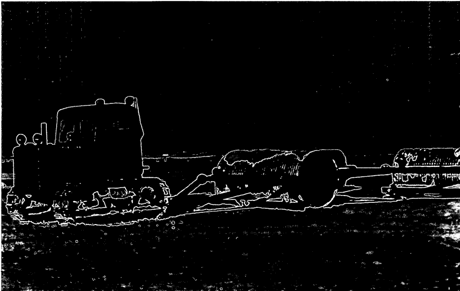
Le compactage de la neige à la 36 ème École de pilotage militaire, à Penhold (Alberta), constituait souvent la meilleure solution au problème de l'entretien des pistes en hiver. (PMR 84-978)
