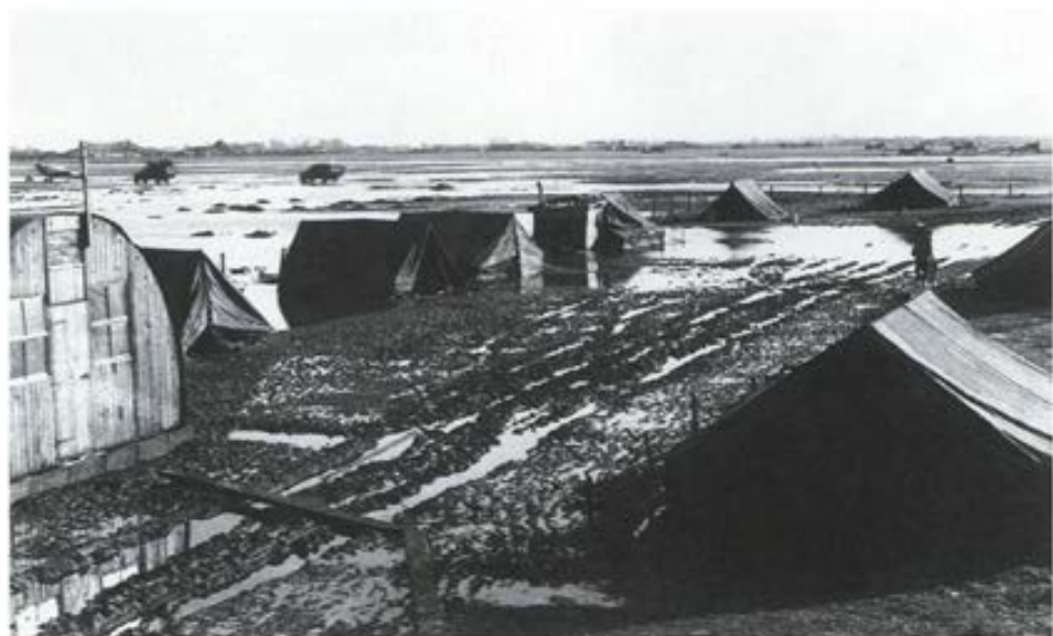
La section inondée des abris de la 39 e Escadre (reconnaissance) à Eindhoven en mars 1945. (Pl. 42674)
