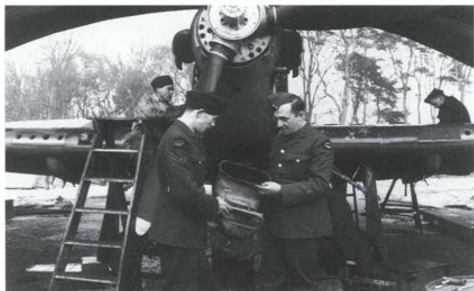
Le personnel non-navigant du 402 e Escadron inspecte l'entrée d'air du carburateur d'un Hurricane IIB. (PL 7121)
