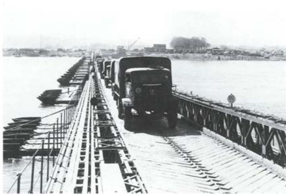
Un convoi de la 143 e Escadre traverse le Rhin sur un pont Bailey de pontons de classe 80, en avril 1945. (PL 44575)
